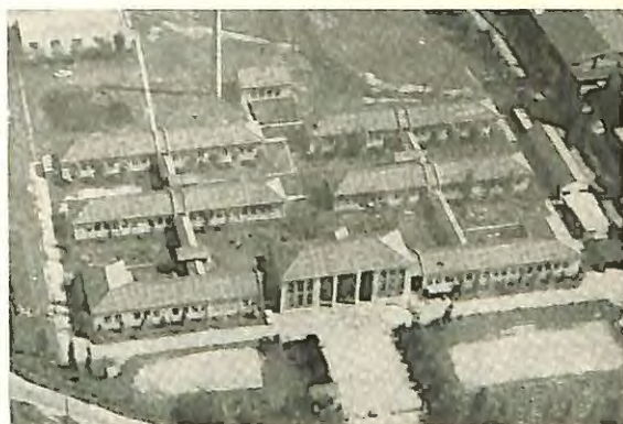
宮城県工業技術センター全景
