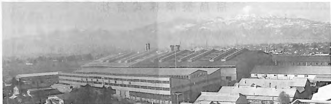
福島製鋼吾妻工場
