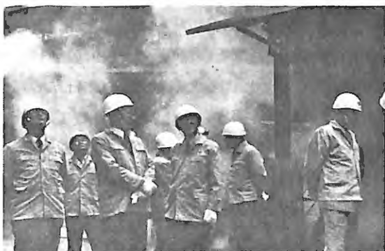
工場見学会（釜石製鉄所）
