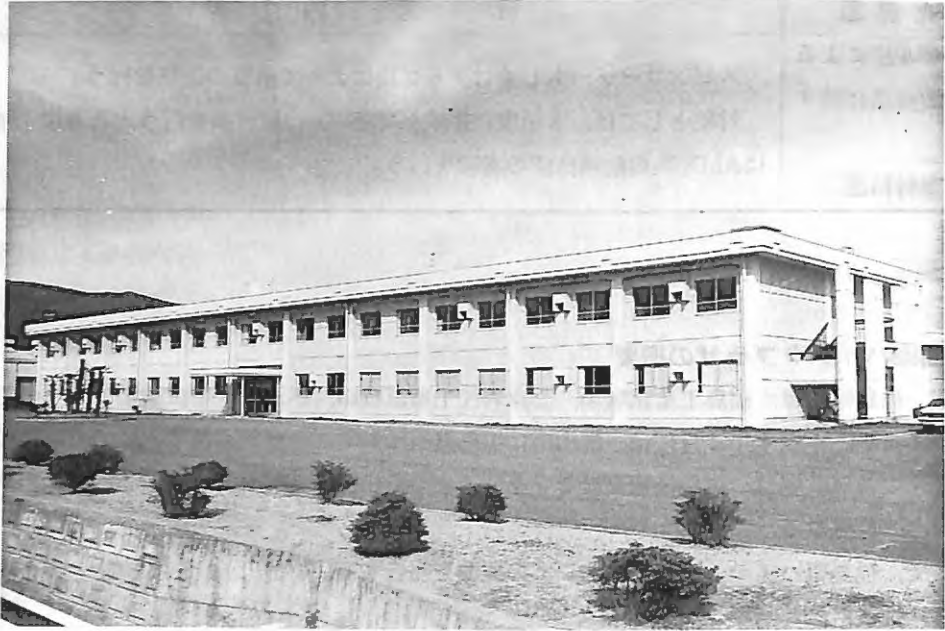
福島工業試験場全景
