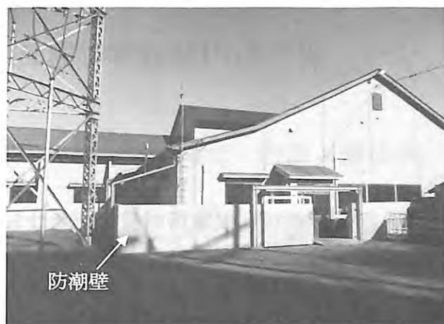
図5 変電所に建設した防潮壁
