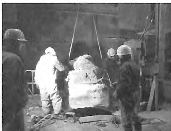
溶解炉から塊の取出し作業
